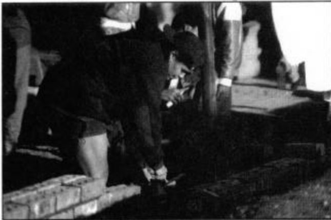
Building a Community Centre - South Africa Construction d'un centre communautaire - Afrique du Sud
